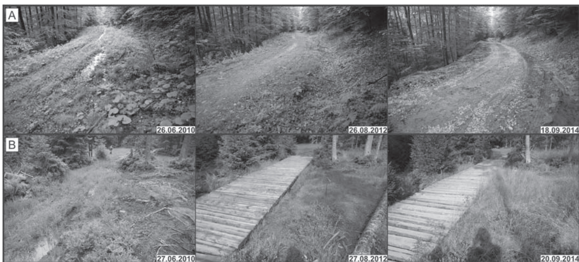
Ryc. 8. A – utwardzenie nawierzchni trasy i konstrukcja poprawnego drenażu pozwoliła na osuszenie powierzchni szlaku. Widoczne zniszczenia wcześniej wyremontowanego szlaku spowodowane przez pojazdy mechaniczne. Stanowisko DPT5, ścieżka edukacyjna „Dolina Potoku Turbacz”; B – dylna drewniana pozwalająca na bezpieczne przejście i chroniąca obszar podmokły przed degradacją. Stanowisko ZT10, szlak żółty.
