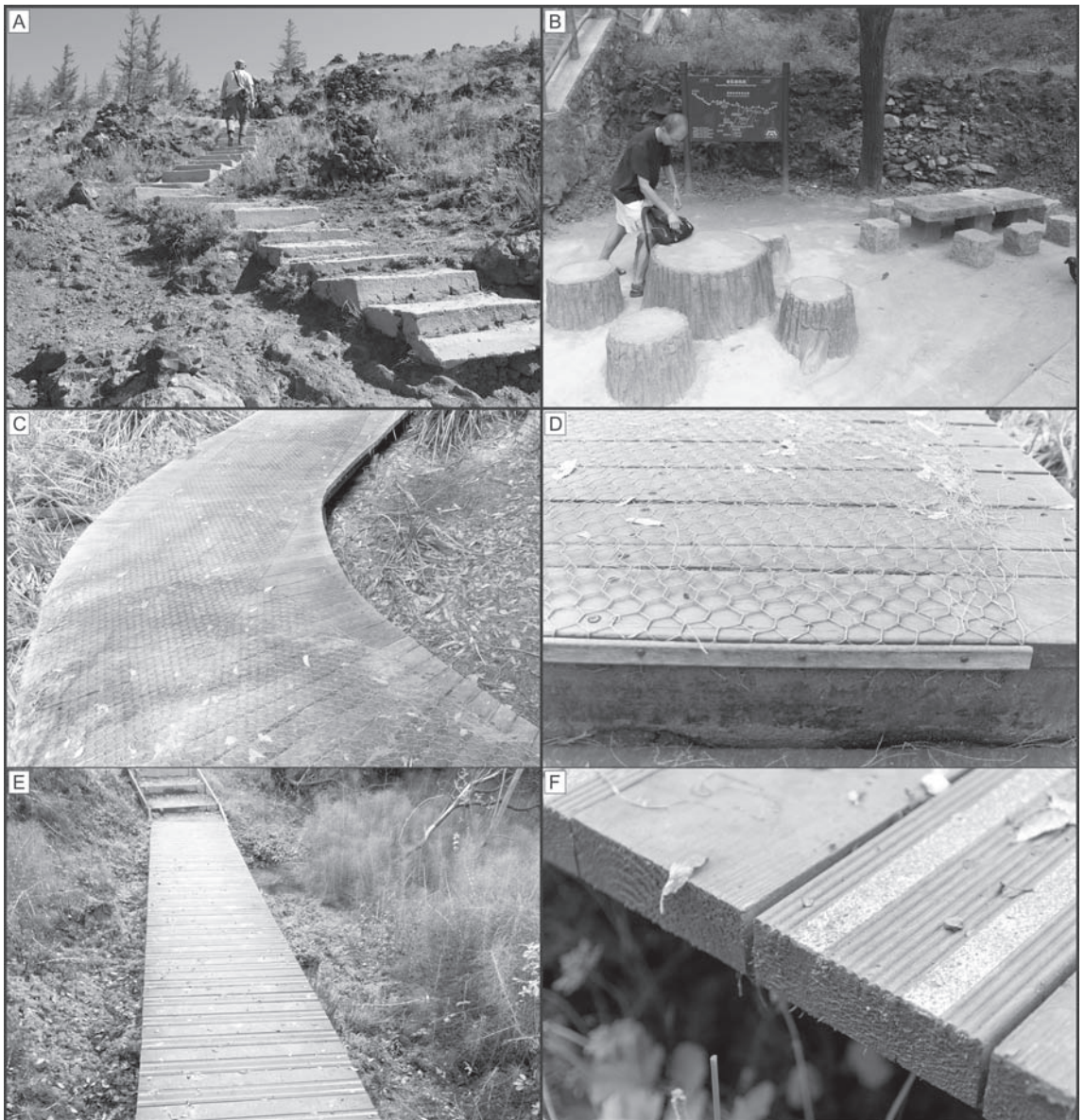
Ryc. 10. Przykłady nieakceptowalnych (A, B) i możliwych do zaakceptowania (C, D, E, F) alternatywnych rozwiązań i ulepszeń związanych z naprawą szlaków. A, B – betonowe elementy infrastruktury, które przyczyniają się do utraty naturalnego charakteru obszaru (A – wygasły wulkan Khorgo, Mongolia; B – Wielki Mur Chiński); C, D – metalowa siatka montowana do dylin, która zapobiega poślizgnięciom. Park Narodowy Walpole-Nornalup, Zachodnia Australia; E, F – kamienne wkładki zapobiegające poślizgnięciom. Park Narodowy North York Moor, Wielka Brytania.
