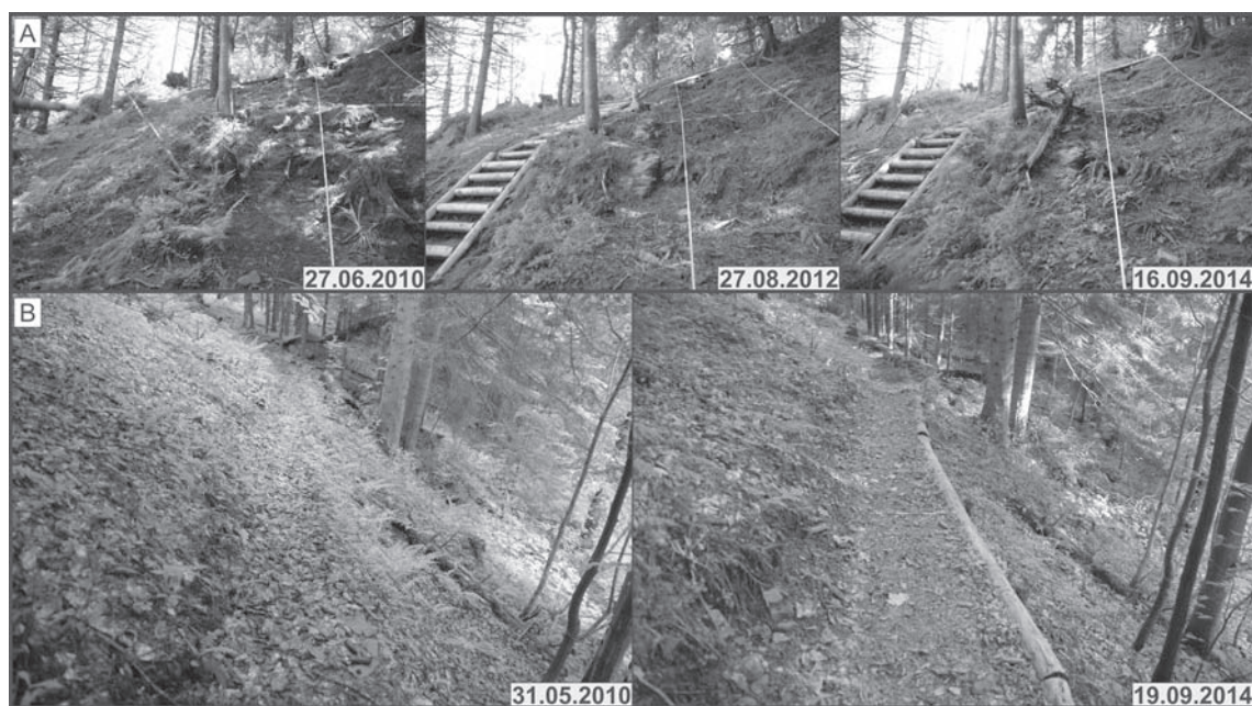
Ryc. 7. A – zmiana przebiegu szlaku połączona z wykonaniem drewnianych stopni przymocowanych do podłużnych belek (konstrukcja typu „drabina”). Strome nachylenie stoku sprawia, że pomimo zaprzestania użytkowania erozja ciągle występuje, a sukcesja roślinności jest powolna. Stanowisko CZ01, szlak czarny; B – drewniane krawężniki zachęcające odwiedzających do pozostania na szlaku. Stanowisko DGP15, ścieżka edukacyjna „Dolina Gorcowego Potoku”.
