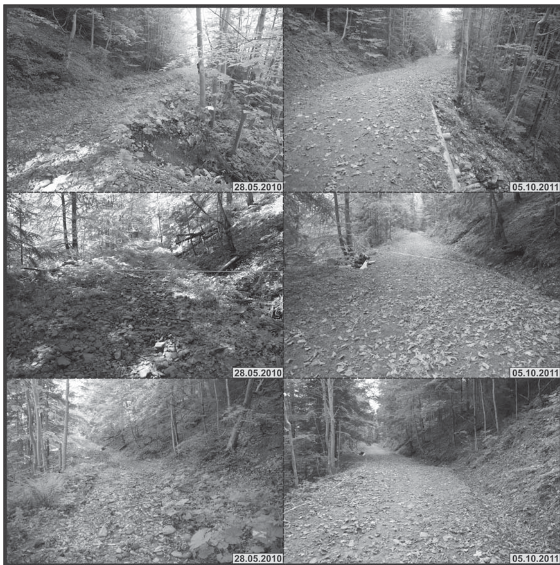
Ryc. 5. Ścieżka edukacyjna „Dolina Gorcowego Potoku”, stan trasy w 2010 i 2011 roku: utwardzenie nawierzchni drogi oraz wykopanie lub udrożnienie rowu odwadniającego po stronie dostokowej w celu zminimalizowania erozyjnej działalności wody, powierzchnia DGP1.
