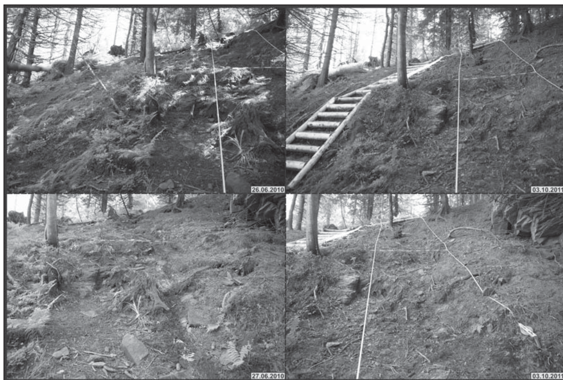
Ryc. 4. Szlak czarny, stan trasy w 2010 i 2011 roku: zmiana przebiegu szlaku w okolicach Kudłonia połączona z budową drewnianych stopni (dwoma taśmami zaznaczono stary przebieg szlaku), powierzchnia CZ1.
