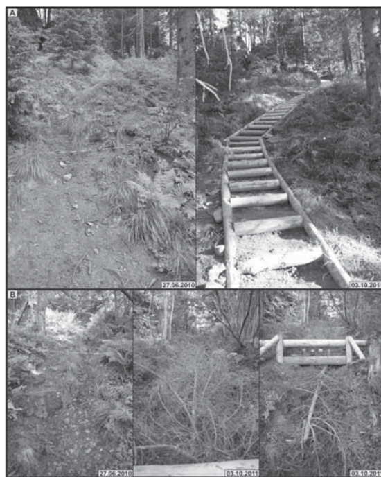
Ryc. 3. Szlak czarny, stan trasy w 2010 i 2011 roku: A – zbudowanie drewnianych schodów sprzyjających skanalizowaniu ruchu turystycznego i ograniczeniu rozdeptywania pobocza szlaku, punkt CZ4; B – skonstruowanie drewnianych barier oraz umieszczenie gałęzi w rynnie erozyjnej, którą prowadził szlak przed zmianą przebiegu, w celu spowolnienia procesów erozyjnych, punkt CZ3.
