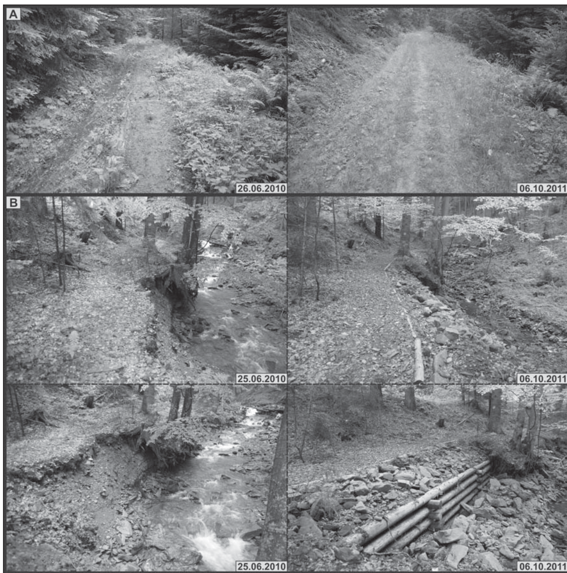
Ryc. 7. Ścieżka edukacyjna „Dolina Potoku Turbacz”, stan trasy w 2010 i 2011 roku: A – utworzenie rowu odwadniającego oraz urządzeń drenujących spowodowało osuszenie nawierzchni trasy, punkt DPT6; B – zbudowanie drewniano-kamiennych barier (kaszyk) ograniczających podmywanie brzegów przez potok, punkt DPT7.
