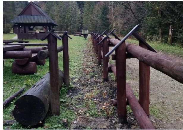
Naprawa ogrodzenia miejsca biwakowego Oberówka oraz założenie żywoplotu bukowego
