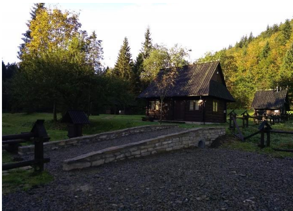
Wymiana infrastruktury technicznej miejsca biwakowego Trusiówka
