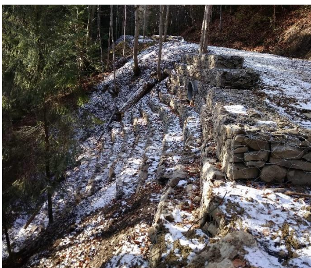
Przepust i zabezpieczenie zbocza
