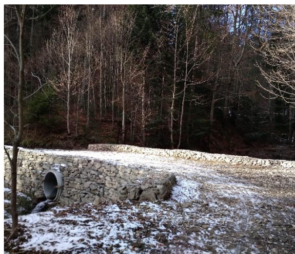
Przepust na Wspólnym Potoku
