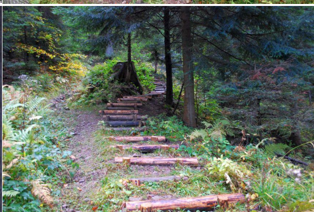
Wymienione zbutwiałe stopnie na czarnym szlaku z Koniny Halamy pod Kope
