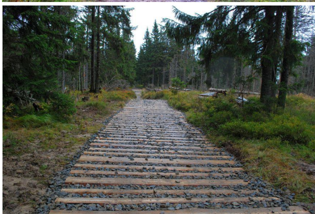
Wymienione dyliny na szlaku zielonym Jaworzyna Kamienicka- Trzy Kopce
