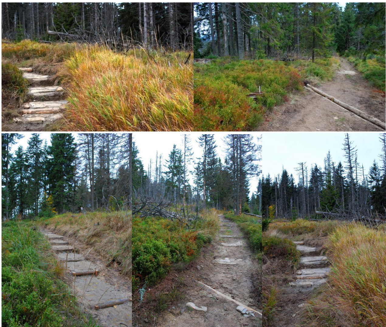
Wykonane prace na żółtym szlaku na odcinku Pustak – Gorc Troszacki
