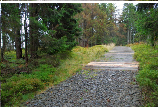
Wymienione dyliny na szlaku zielonym Jaworzyna Kamienicka- Trzy Kopce
